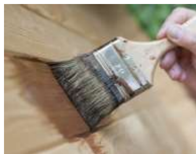
выполнение работ по огнезащите материалов, изделий и конструкций
