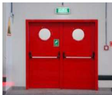
организация проемов в противопожарных преградах
